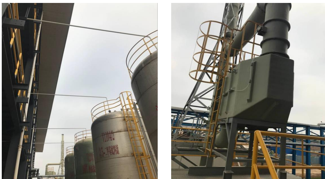
图 4.1-1 储罐废气收集处理系统图
