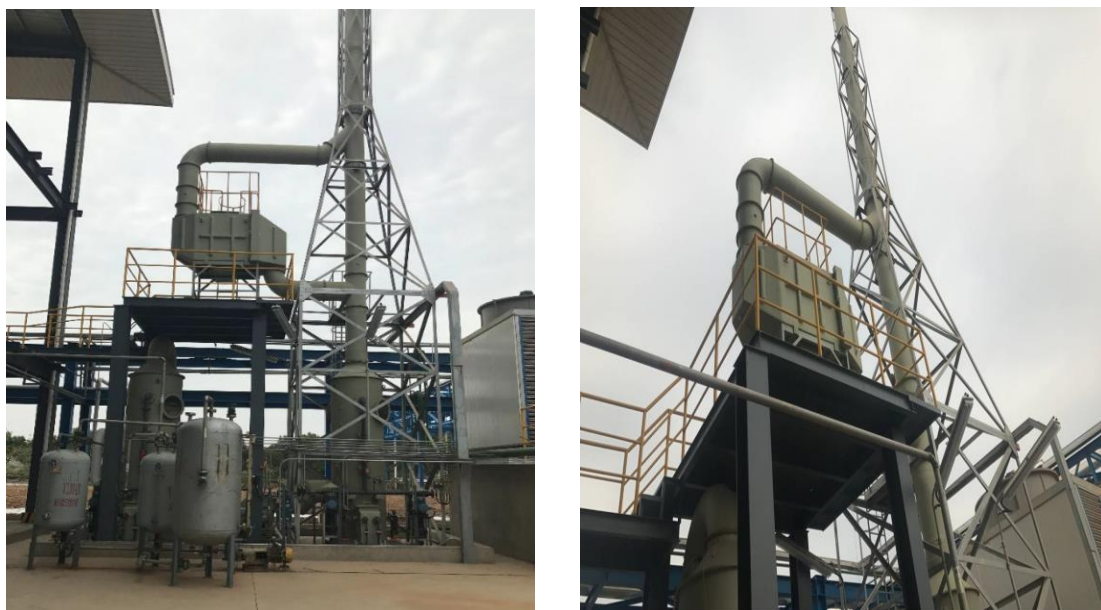
图 1.3-1 “水喷淋+活性炭吸附”处理装置图
