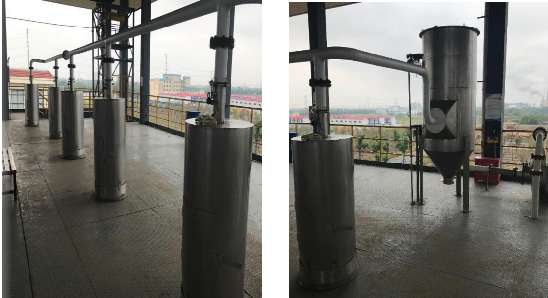
图 1.3-2 “布袋除尘器” 处理装置图
