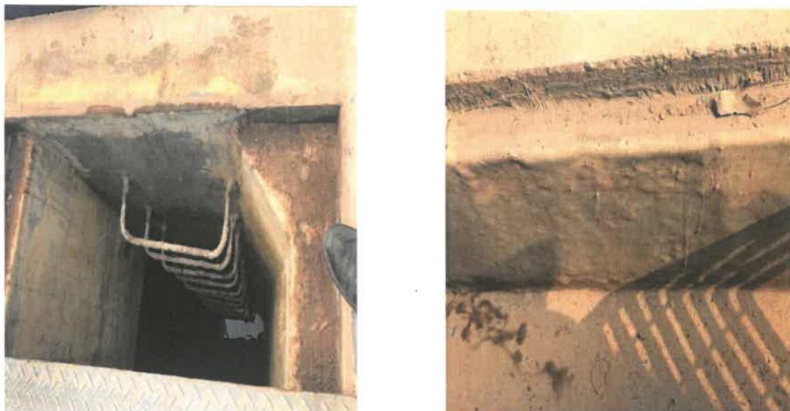
图 1.3-6 厂区内收集水池及围堰图
