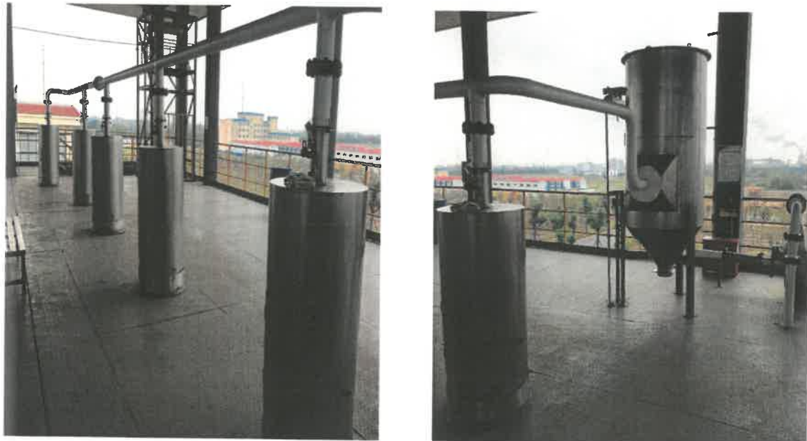
图 1.3-2“布袋除尘器”处理装置图
