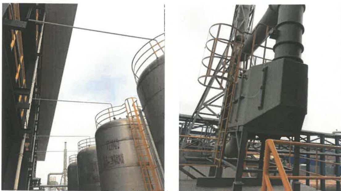
图 4.1-1 储罐废气收集处理系统图
