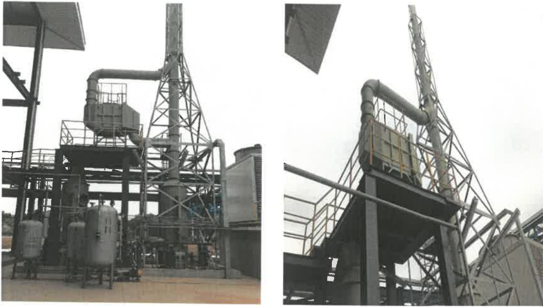
图 1.3-1“水喷淋+活性炭吸附”处理装置图
